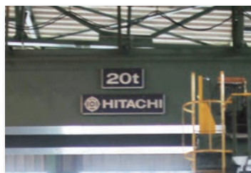
20tクレーン
